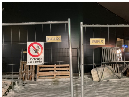
Bild 47. Information om byggprojektet saknas.
